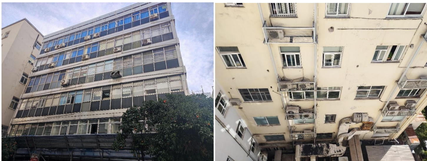
Εικόνα 20&21: Εξωτερικές μονάδες κλιματισμού στις όψεις του κτιρίου
