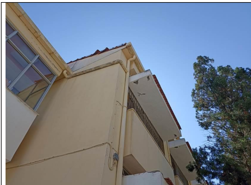
Λεπτομέρεια της δυτικής όψης κτιρίου του Γυμνασίου – στην θέση της εισόδου
