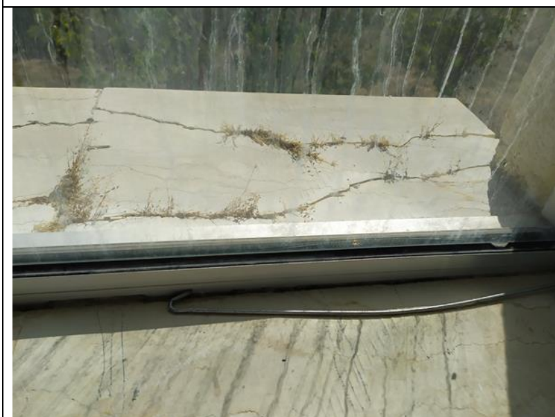
Άποψη φθορών στις μαρμαροποδιές των παραθύρων (ανατολική οψη)
