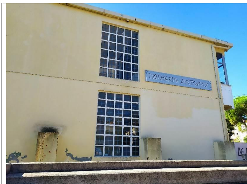
Άποψη του κτιρίου του Γυμνασίου από τον δρόμο (βόρεια όψη)
