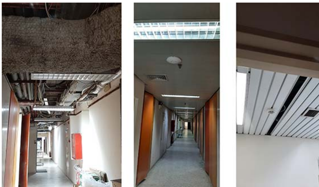
Ψευδοροφές: Υπόγειο /Διάδρομοι / Χώροι ανάμεσα στους διαδρόμους
