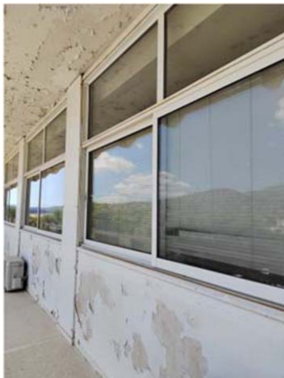
N όψη: συρόμενα επάλληλα, φεγγίτης ανοιγόμενος, «τυφλό» τμήμα / B όψη: συρόμενα επάλληλα, φεγγίτης σταθερός
