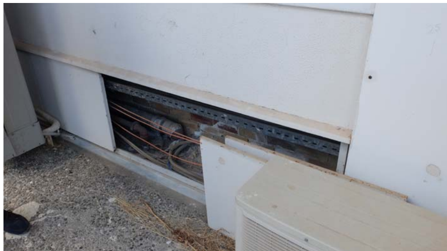
«ταμπλάδες» πρόσβασης σε Η/Μ εγκαταστάσεις στη Β όψη
