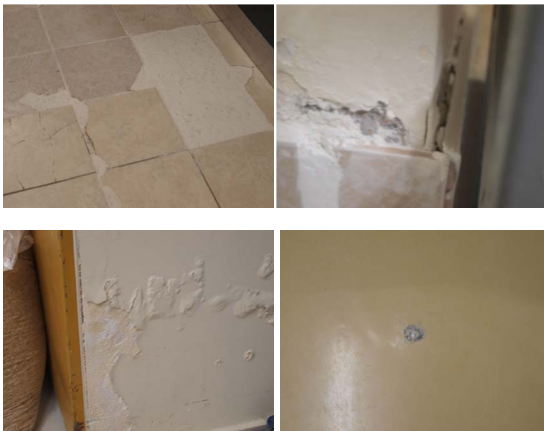
Υγρασίες στους χώρους των πειραματόζων
