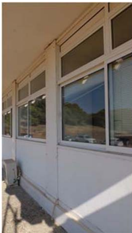
N όψη: συρόμενα επάλληλα, φεγγίτης ανοιγόμενος, «τυφλό» τμήμα / B όψη: συρόμενα επάλληλα, φεγγίτης σταθερός
