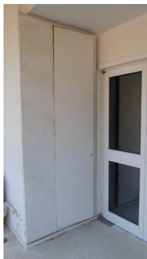
«ταμπλάδες» πρόσβασης σε Η/Μ εγκαταστάσεις στη Β όψη
