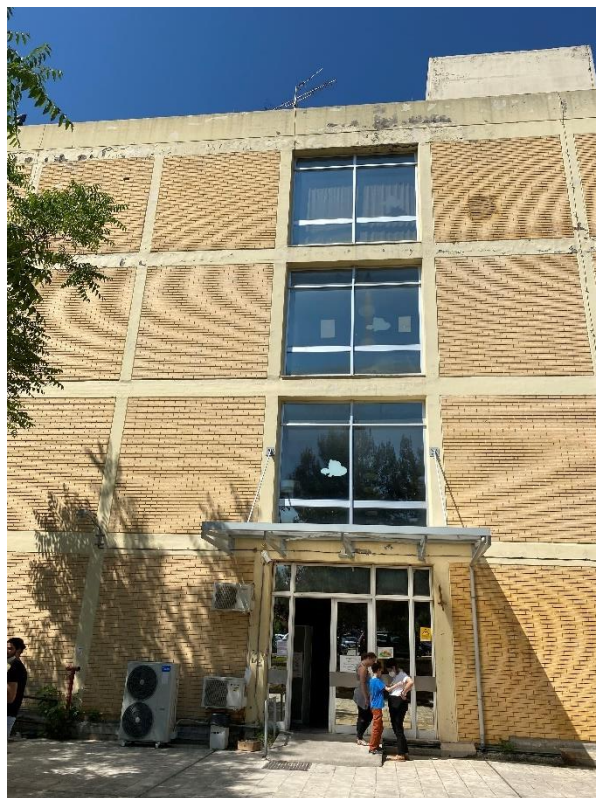
Εικόνα 15: Κουφώματα Δυτικής όψης
