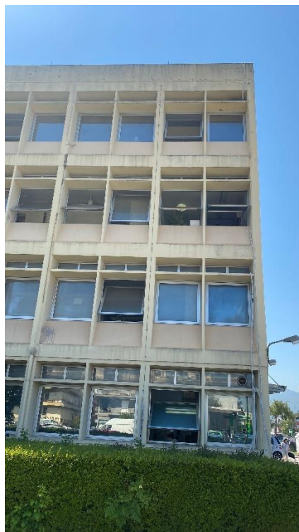
Εικόνα 17:Κουφώματα Νότιας όψης
